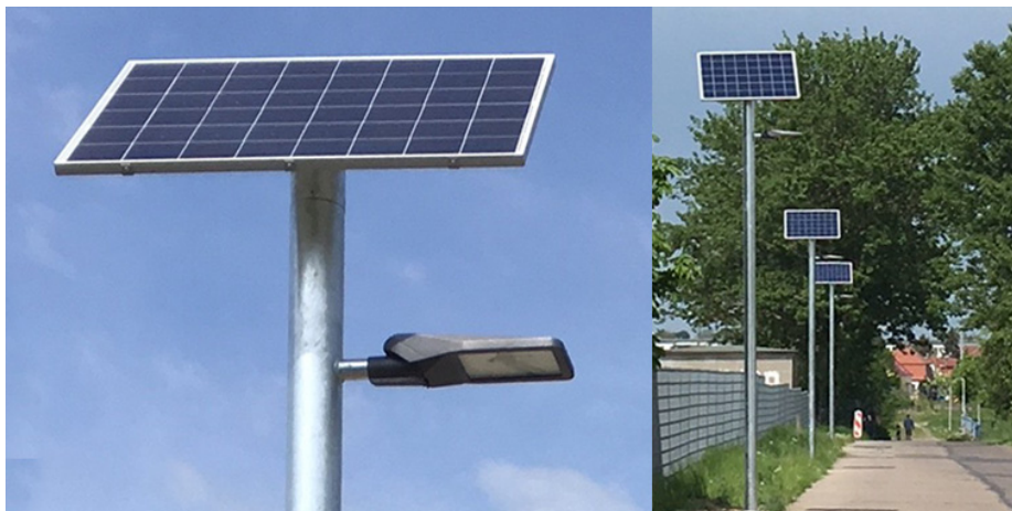
12 Solarlaternen stehen in der Koitenhäger Landstraße. Derzeit werden 45 weitere Solarleuchten in der Straße Am Gorzberg montiert. Quelle: Degrassi Katharina
